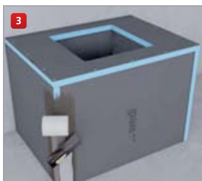
... vyztužte spoje armovací páskou ...
