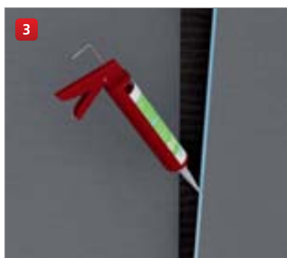
... utěsněte a vyztužte spoje armovací páskou ...
