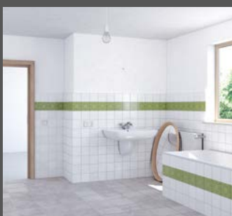
Renovace – výchozí situace
